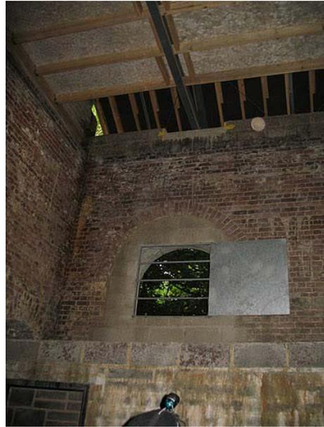
Ouvertures pratiquées dans la façade du bâtiment. Un espace de 60 cm a été maintenu ouvert entre le sommet du mur et la toiture. Noter en bas des photos le tunnel construit avant la réfection de la toiture et permettant de relier deux parties du bâtiment (© P. Nyssen)
