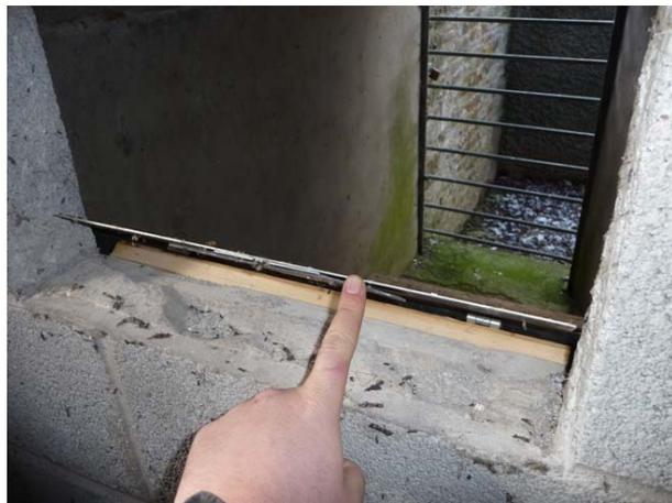
Dispositif anti-prédateurs avec appui de fenêtre basculant (© P. Nyssen & C. Borel)
